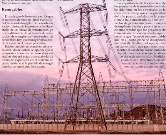
La línea de transmisión Cardones-Polpaico sufrió importantes retrasos ante la oposición de comunidades locales a su construcción.
